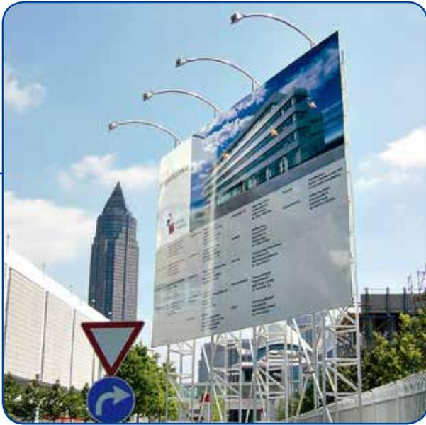
Bauschild mit Triotraverse und Fundamenten als Mietunterkonstruktion inkl. Beleuchtungsgarnitur.
