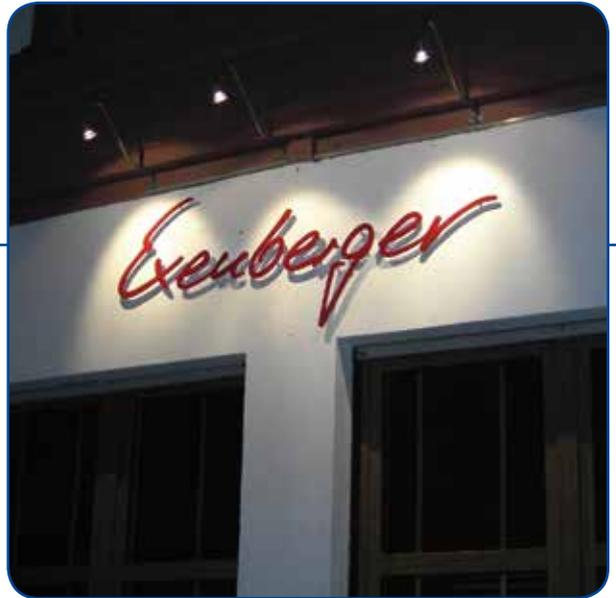
Einzelbuchstaben aus 8 mm Acrylox (durchgefärbter Kunststoff), Montage mit Wandabstandshaltern.
