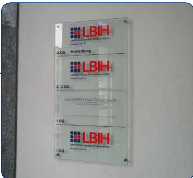
Wegweiser aus ESG-Glas, montiert mit Wandabstand. Beschriftung im Folienplott.
