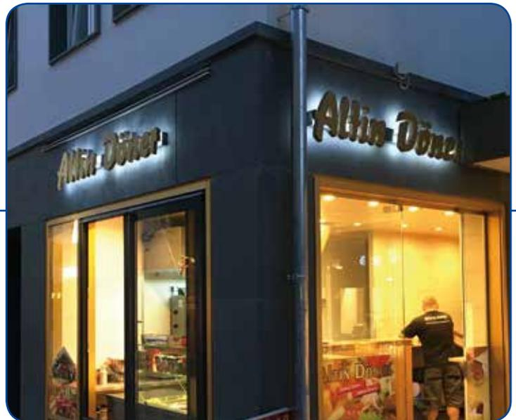
Transparentkasten aus Aluminium. Logo negativ aus Haube dekupiert und flach mit farbigem Acrylglas hinterlegt. Mit LED ausgeleuchtet.
