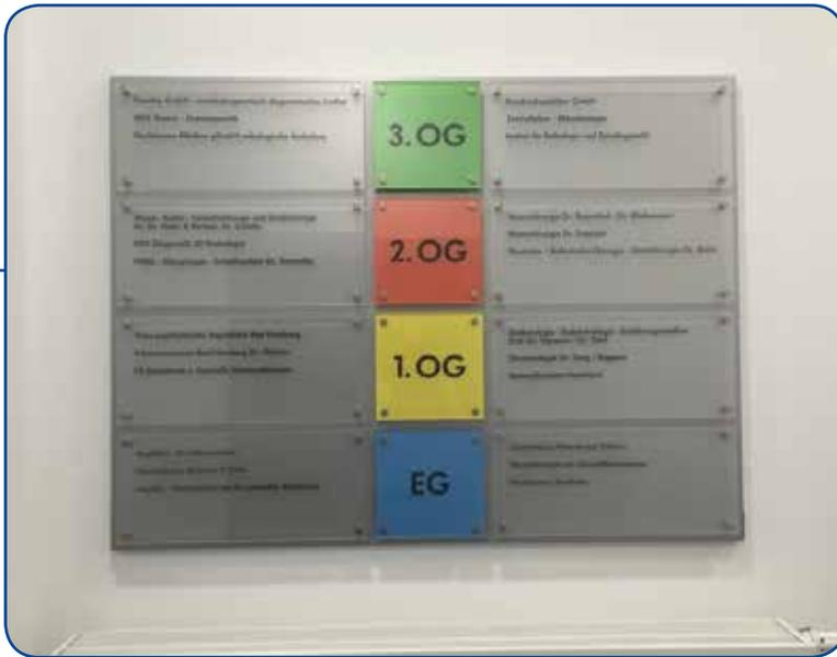
Leitsystem bestehend aus einem gekanteten Alublech als Trägerplatte und ESG-Glas als Beschriftungsfläche für Etagen- und Mieterhinweise.
