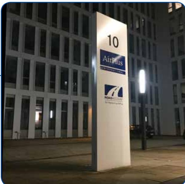
Unbeleuchtete Aluminium Stele mit Tragwerk aus Stahl. Beschriftung im Plottverfahren.
