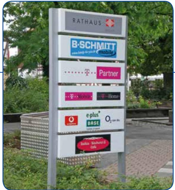
Aluminiumstele, Logo dekupiert, flach mit Plexiglas hinterlegt und hinterleuchtet. ESG-Glasflächen zur Mieterbeschriftung.
