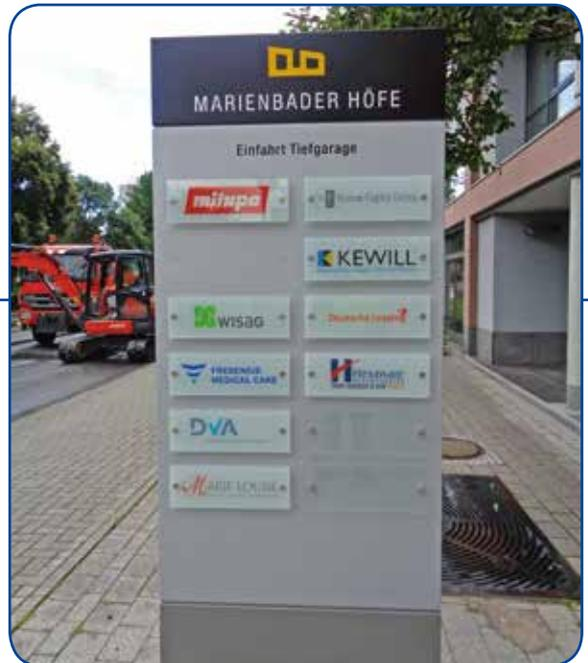
Unterkonstruktion mit Rahmenvorrichtung aus Stahl, gekanteten und beschrifteten Alublechen, Ronden als Leuchttransparente gefertigt.
